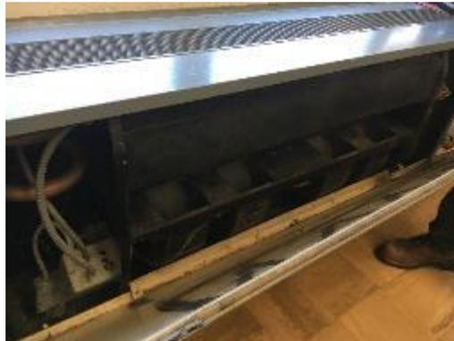
*Figure 9-Unit Ventilator*
